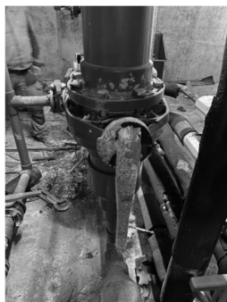
Foto 1. Estat claus accionament dels circuits dels vasos.
